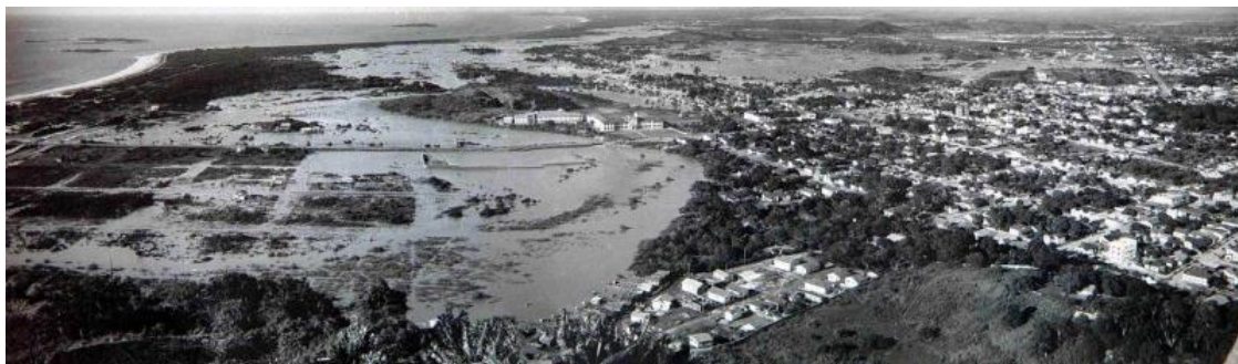
Figura 2 – Enchente ocorrida em 1960 em Vila Velha – ES, vista do Morro do Convento.
