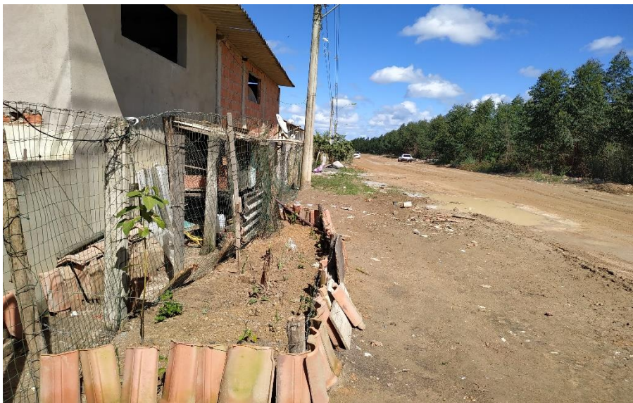
Foto 04 – Local para implantação da pavimentação.
