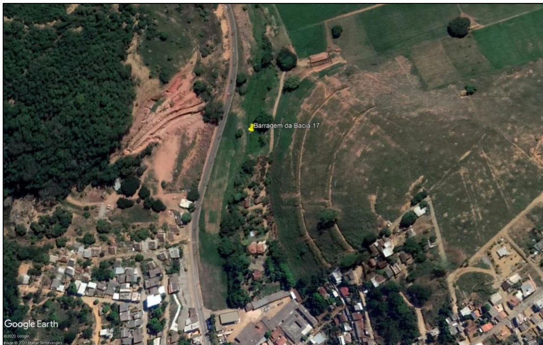
Figura 01 – Foto aérea do local da barragem da bacia 17
