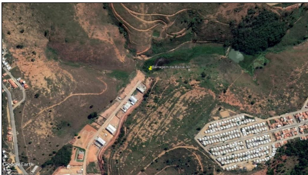
Figura 02 – Foto aérea do local da barragem da bacia 30
