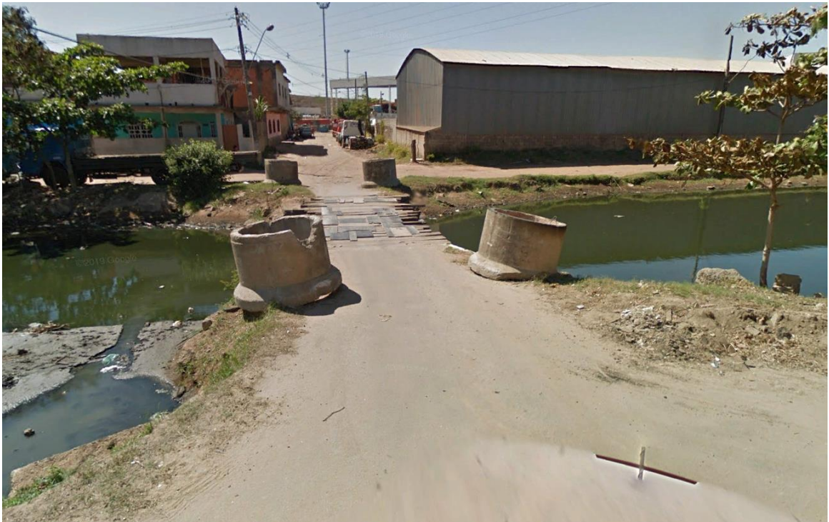
FIGURA 17: PONTE DA RUA MARGARIDA SOBRE O RIO ARIBIRI
