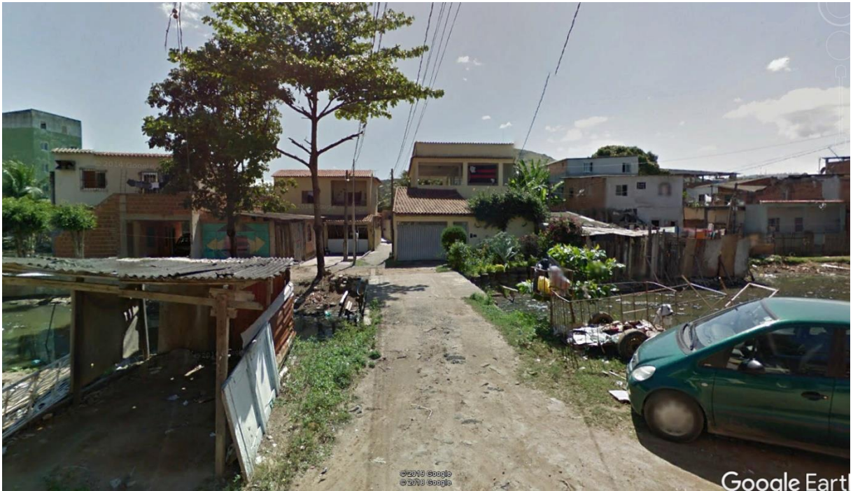
FIGURA 20: PASSARELA DA RUA LEOPOLDO TEMPERÂNEO
