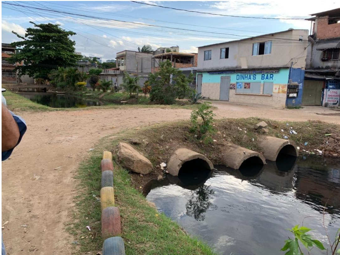
FIGURA 18: RUA SÃO FRANCISCO XAVIER, LOCAL DE IMPLANTAÇÃO DA PONTE 1
