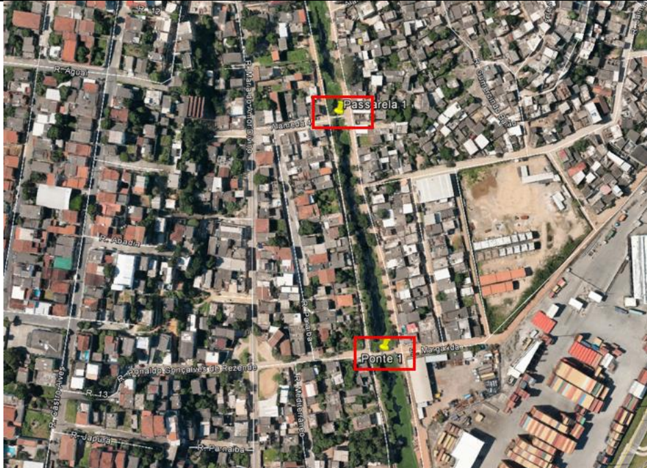
Figura 2 – Ponte 1 e Passarela 1 sobre Canal Aribiri
