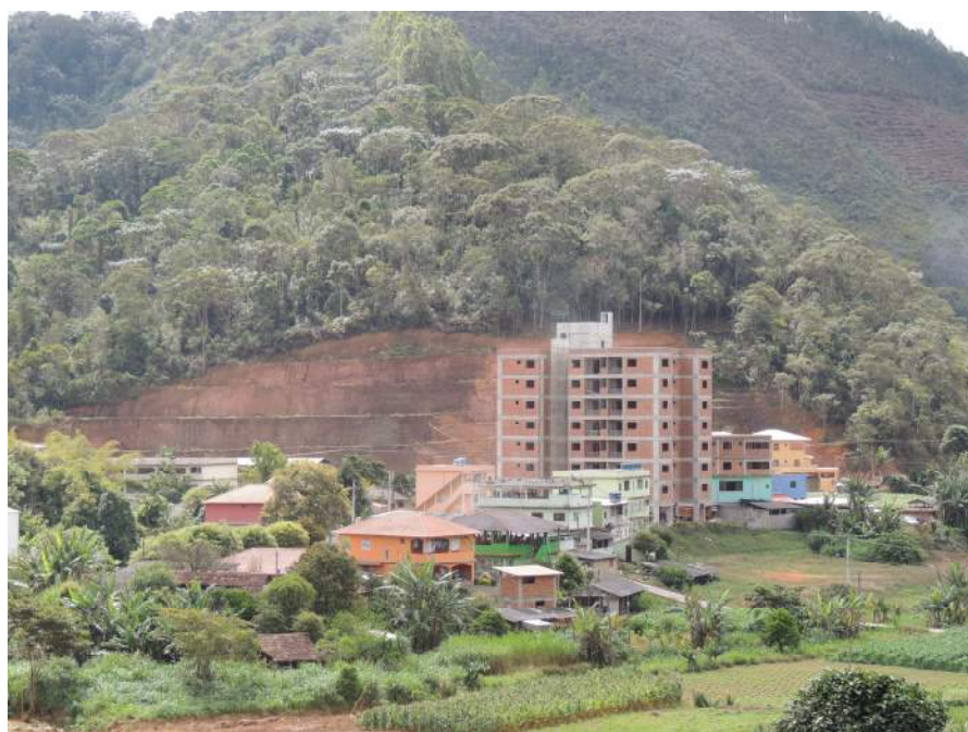
Foto 23 – Vista panorâmica do setor de risco.
