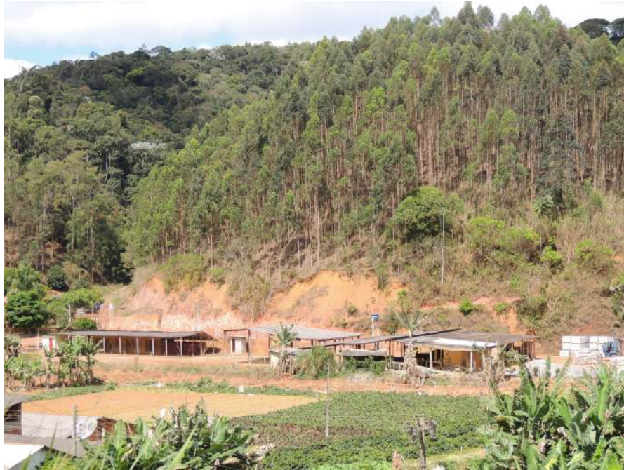
Foto 30 – Indícios de instabilidade ao longo da encosta.
