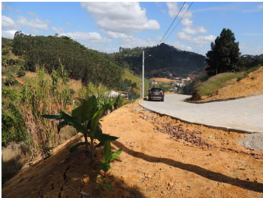
Foto 41 – Via de acesso recentemente pavimentada a montante do setor.
