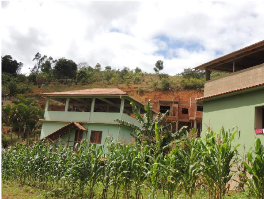
Foto 15 – Vista frontal do setor de risco.
