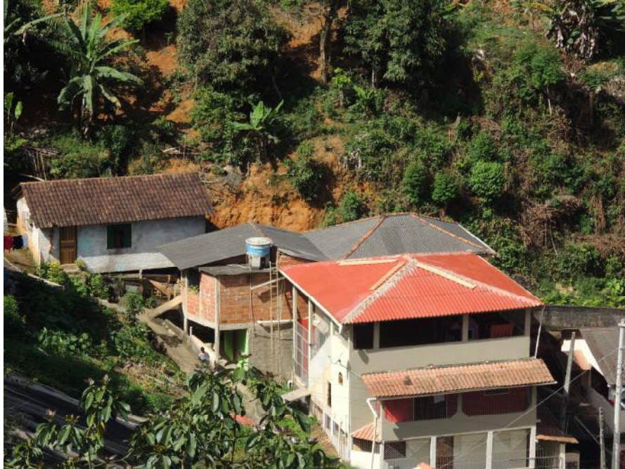
Foto 35 – Detalhe para talude nos fundos de um domicílio com indícios de instabilidade.
