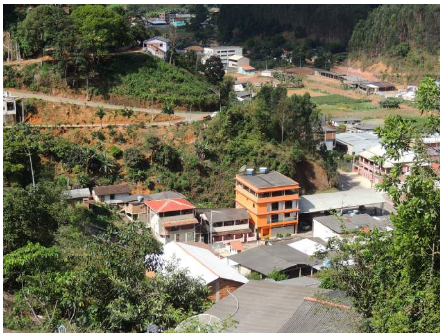
Foto 34 – Ocupação da base do talvegue com cartes verticais com alturas acima de 10,0m.
