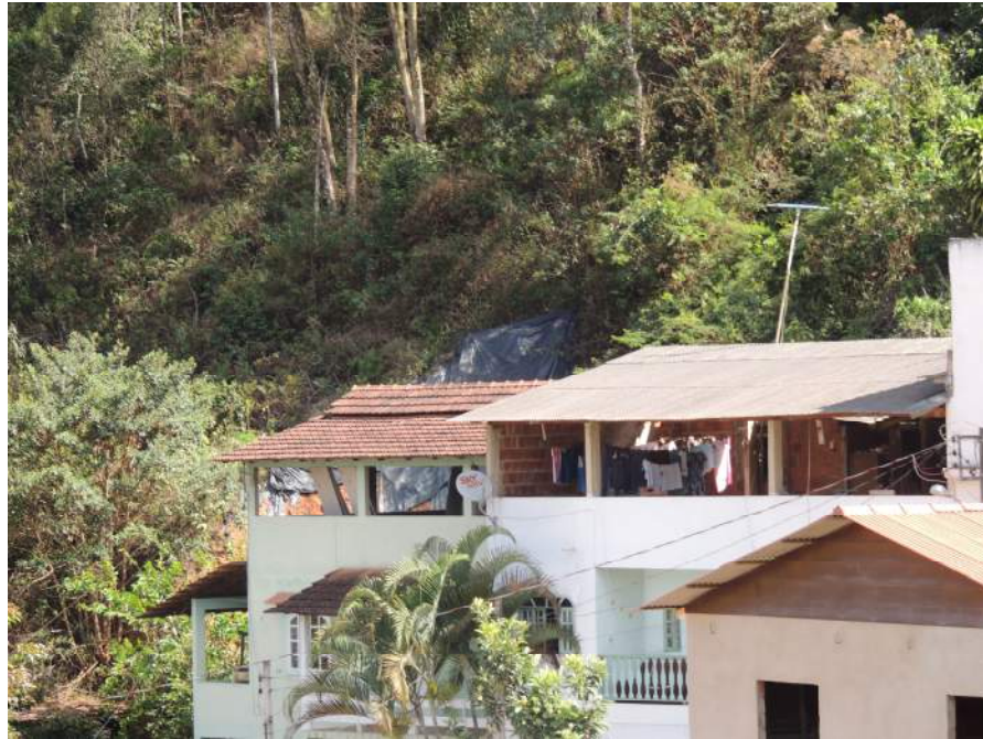
Foto 44 – Vista aproximada em relação ao trecho onde ocorreu deslizamento.
