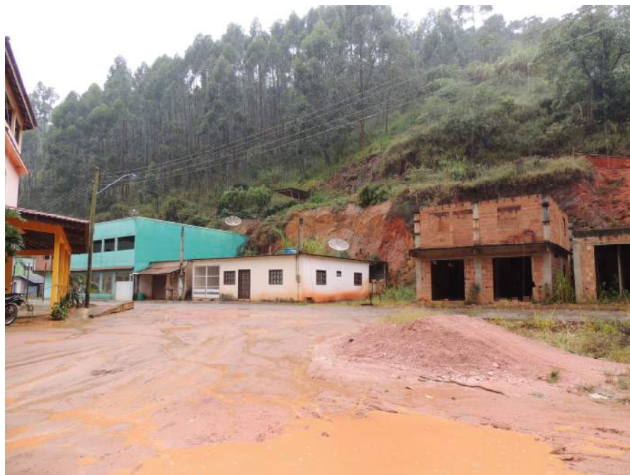
Foto 50 - Vista parcial do setor de risco. Substrato rochoso na base impermeável e solo residual instável. Indícios de movimentação do terreno.
