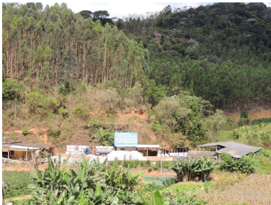
Foto 29 - Domicílios de baixo padrão construtivo e corte vertical no talude.
