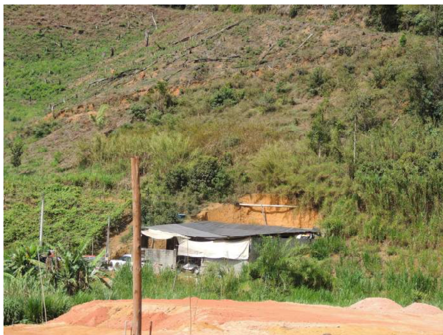
Foto 28 – Domicílio de baixo padrão construtivo e corte vertical no talude.
