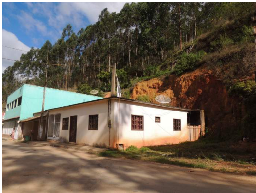
Foto 51 - Vista parcial do setor de risco. Substrato rochoso na base impermeável e solo residual instável. Indícios de movimentação do terreno e domicílios de baixo padrão construtivo.
