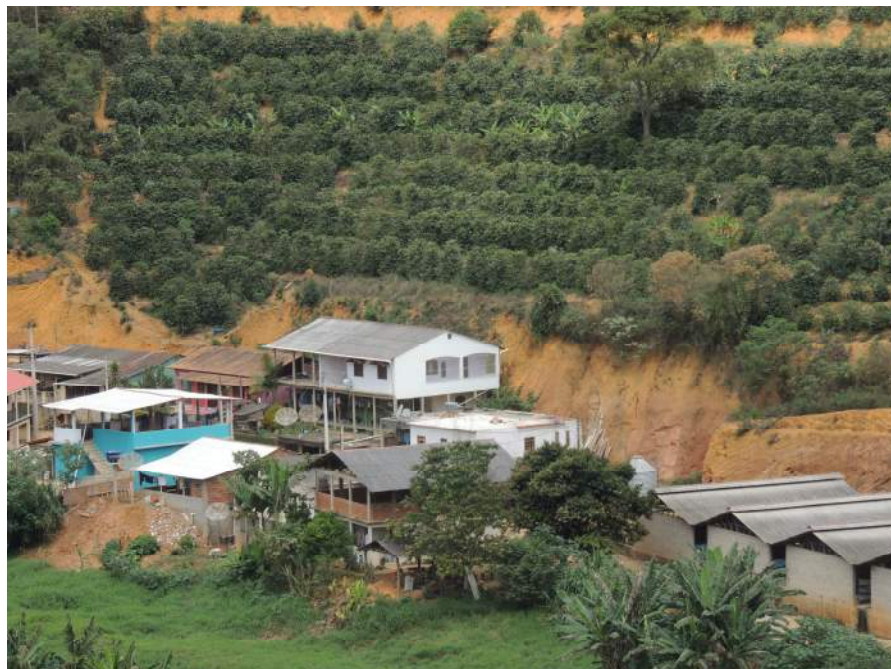
Foto 6 – Detalhe para a altura dos taludes e inclinação acentuada.
