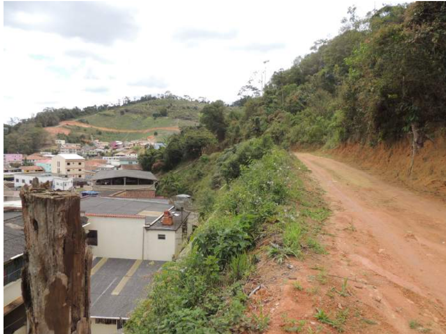
Foto 10 – Vista parcial do setor. Via de acesso na crista não pavimentada.
