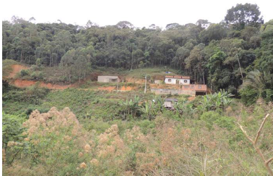
Foto 16 – Vista parcial do setor. Área sendo ocupada por meio de corte instável e não contidos adequadamente.
