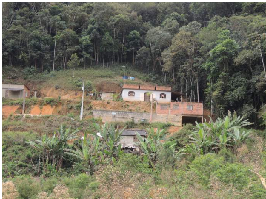
Foto 18 - Vista aproximadamente exemplificando a tipologia de ocupação.
