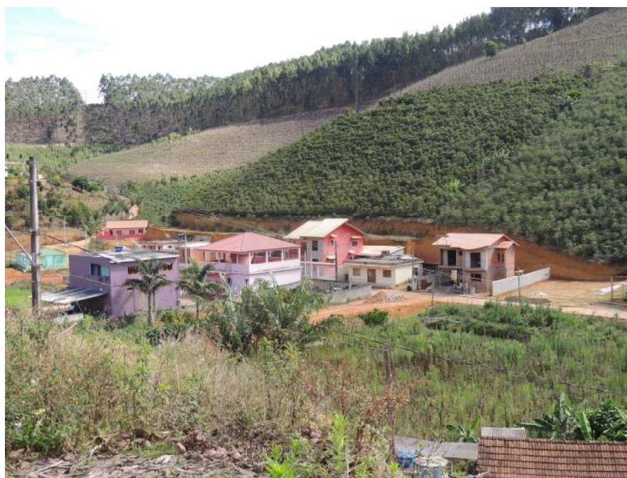
Foto 33 - Domicílio de bom padrão construtivo e cortes verticais no talude.
