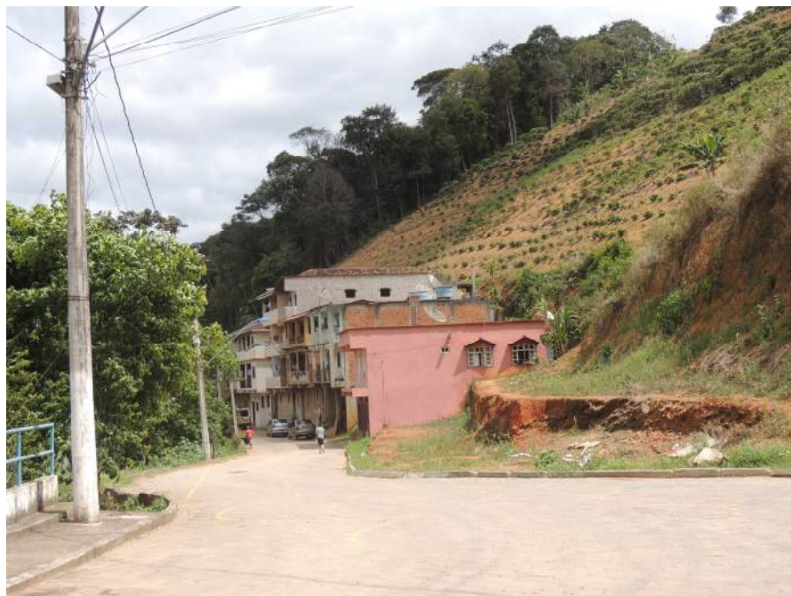
Foto 8 – Vista oposta em relação ao setor de risco.
