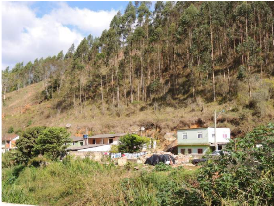
Foto 53 - Vista frontal do setor de risco. Substrato rochoso na base impermeável e solo residual instável. Indícios de movimentação do terreno e domicílios de baixo padrão construtivo.
