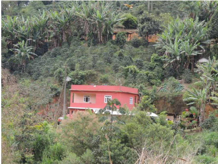
Foto 19 – Domicílio de bom padrão construtivo mas com taludes verticais com angulações inadequadas.
