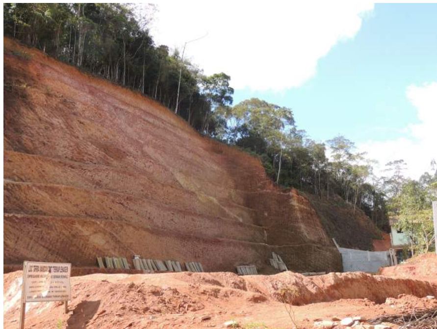
Foto 25 – Vista do talude a partir da base da encosta.
