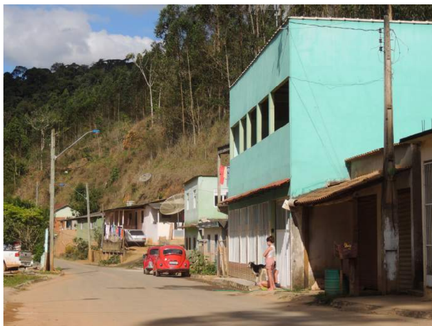
Foto 52 - Vista parcial do setor de risco. Substrato rochoso na base impermeável e solo residual instável. Indícios de movimentação do terreno e domicílios de baixo padrão construtivo.
