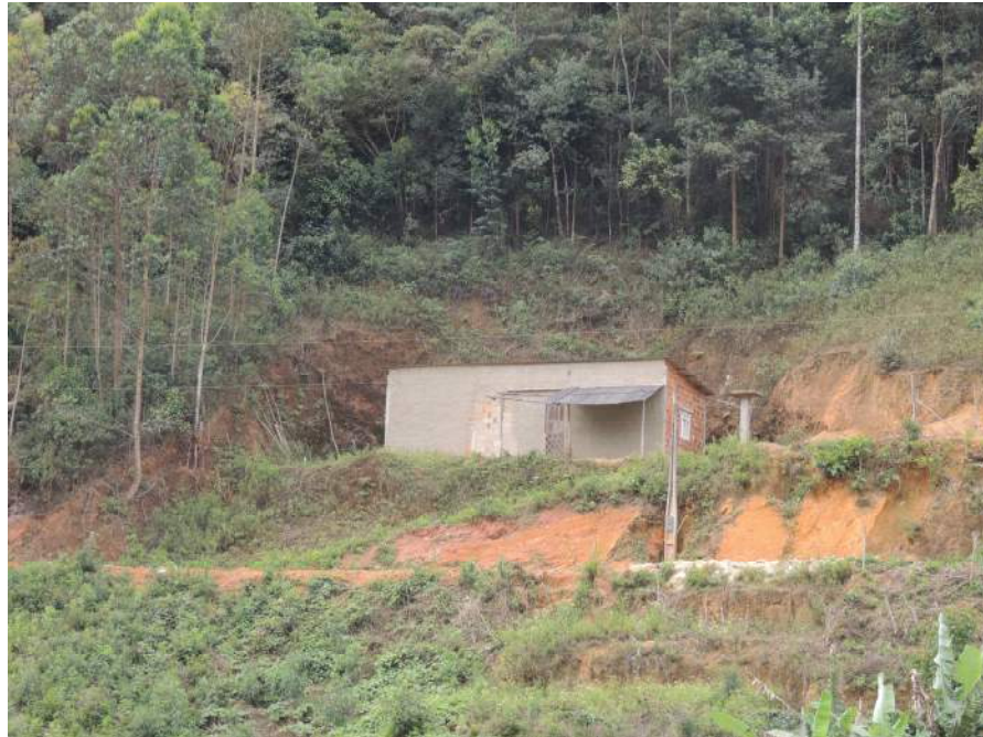
Foto 17 – Vista aproximadamente exemplificando a tipologia de ocupação.
