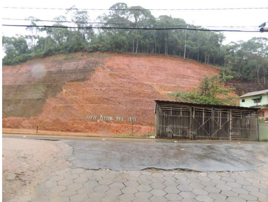
Foto 22 – Vista frontal do trecho que está sendo retalhado.
