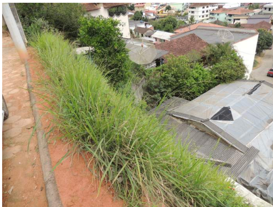
Foto 9 – Setor de risco geológico e desnível do topo em relação a base do talude.
