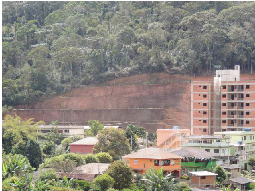
Foto 24 – Vista panorâmica do setor de risco. Notar dimensão do talude.
