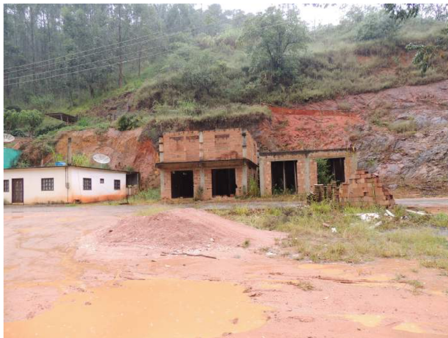
Foto 49 – Vista parcial do setor de risco. Substrato rochoso na base impermeável e solo residual instável. Indícios de movimentação do terreno.
