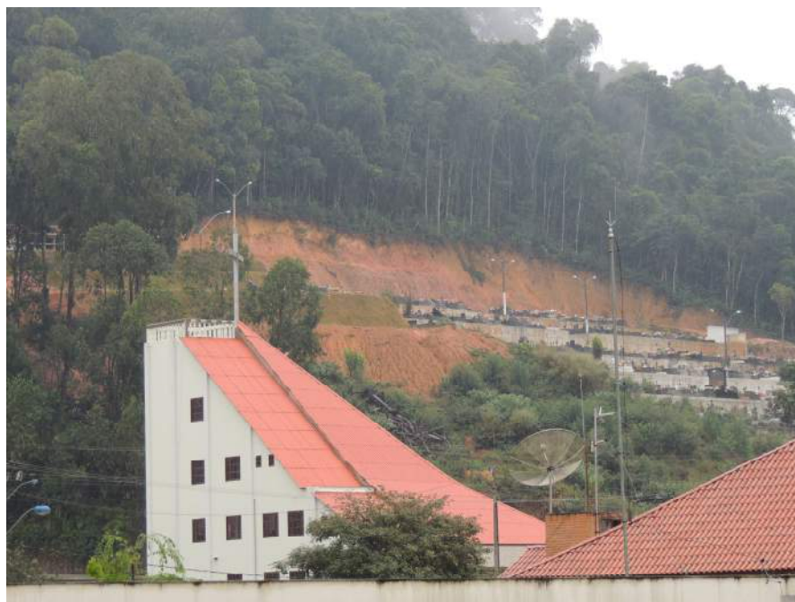
Foto 12 – Área do cemitério e indícios de instabilidade ao longo da encosta.
