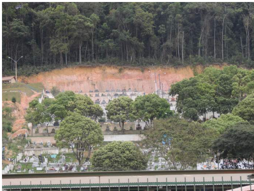
Foto 13 – Vista parcial frontal da área.
