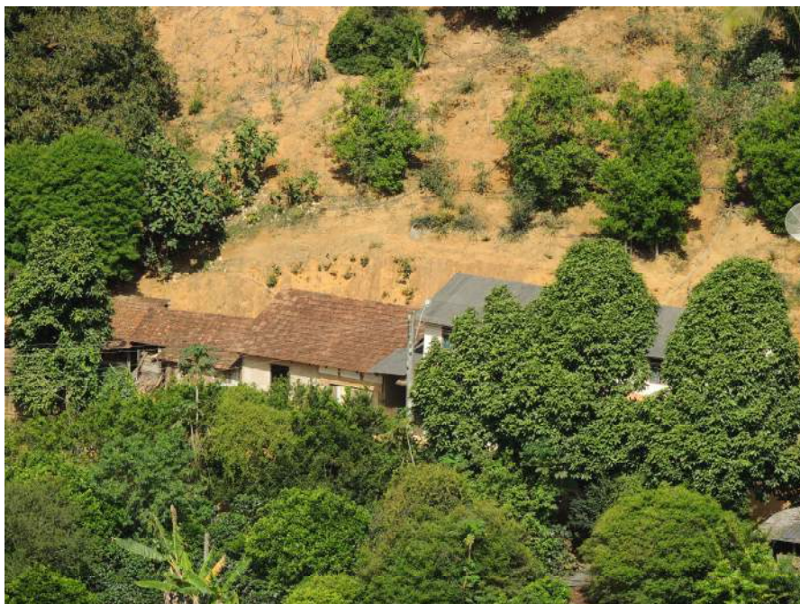
Foto 37 - Vista aproximada de parte do setor de risco.
