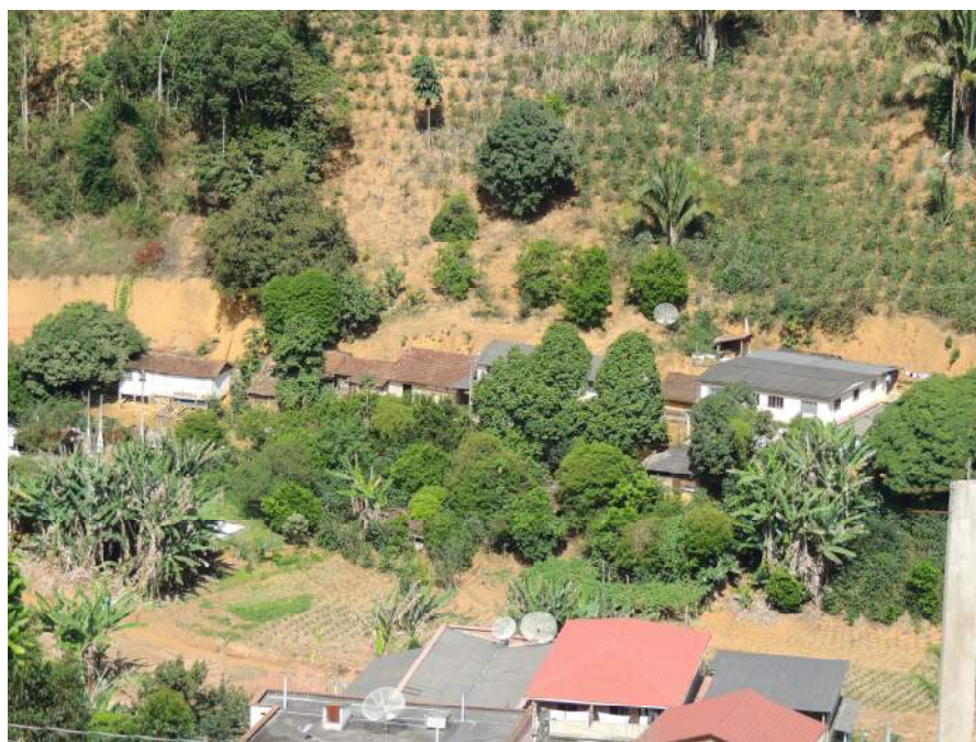
Foto 36 - Domicílio de baixo padrão construtivo e cortes verticais no talude.
