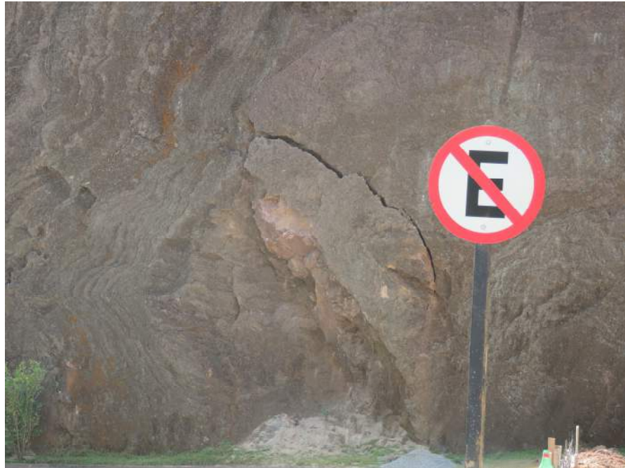
Foto 26 – trechos com rupturas em solo ao longo da encosta.
