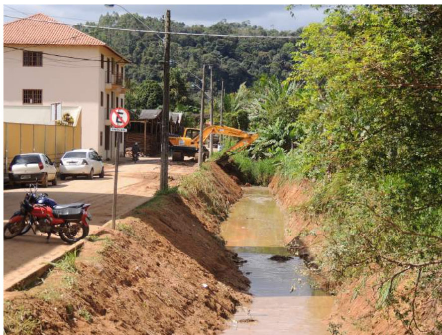
Foto 31 – Canal após processo de limpeza.
