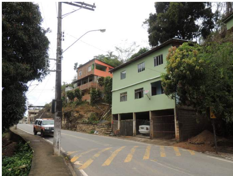
Foto 36 – Vista frontal do setor de risco. Domicílio de médio padrão construtivo.
