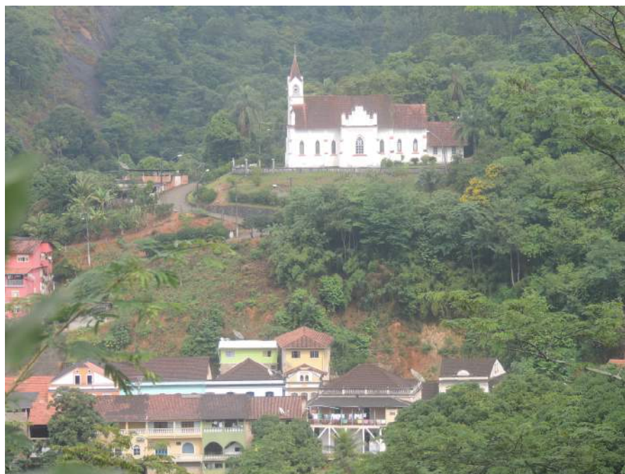
Foto 10 – Vista frontal do setor de risco a jusante da Igreja Matriz.
