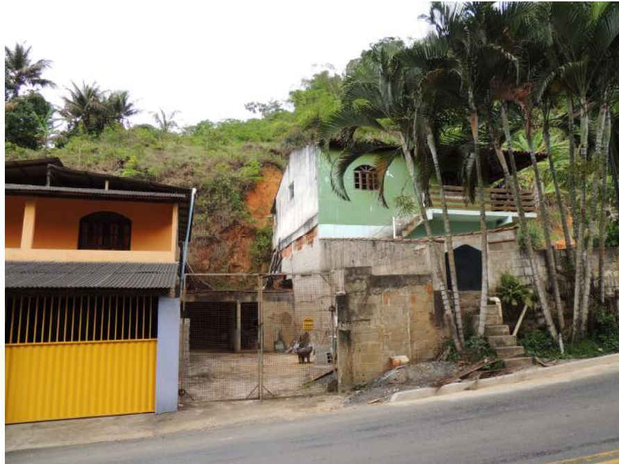
Foto 20 – Detalhe para os taludes de corte nos fundos dos domicílios.
