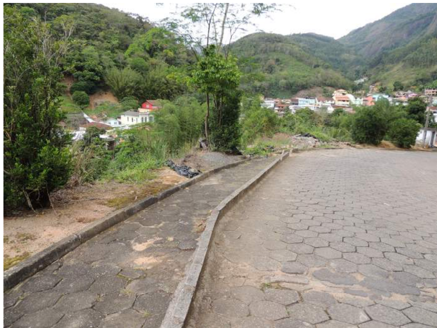
Foto 3 – Detalhe para a via veicular a montante do setor onde já foi feito uma guia para redirecionamento do escoamento superficial.
