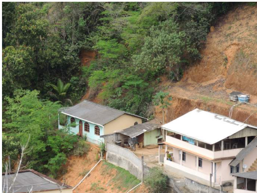
Foto 8 – Detalhe para domicílio de baixo padrão construtivo muito próximo ao talude.
