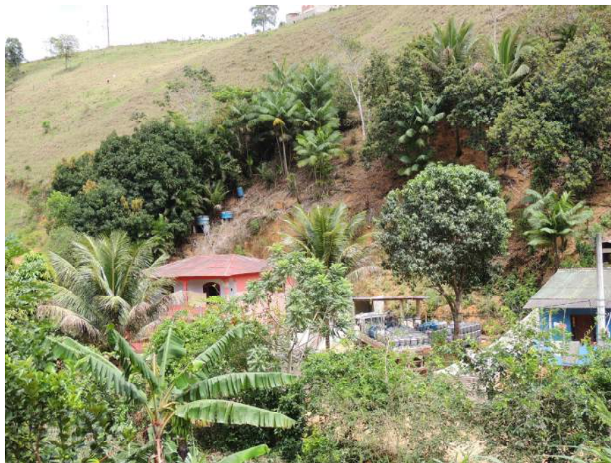
Foto 9 – Vista frontal do setor de risco.
