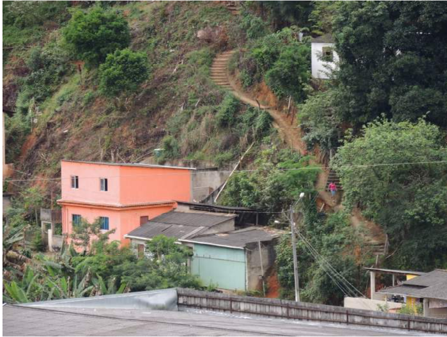
Foto 25 – Vista aproximada com detalhes para os taludes de corte nos fundos dos domicílios.
