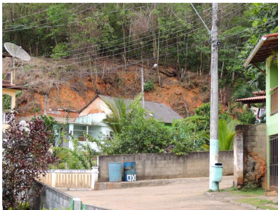
Foto 30 – Vista a partir da base do setor de risco.
