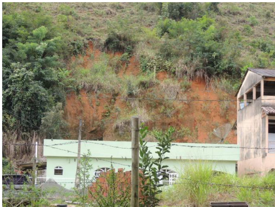
Foto 38 - Indícios de instabilidade a montante dos domicílios.
