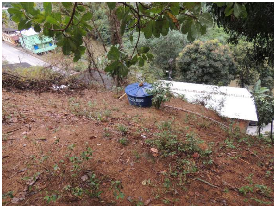
Foto 35 – Vista de montante para jusante do setor de risco.
