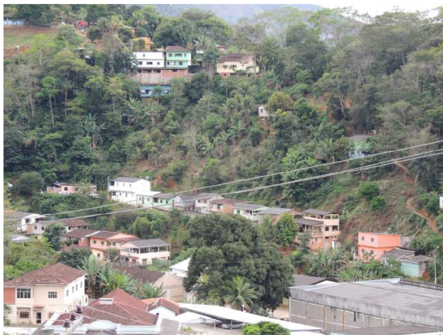
Foto 23 – Vista panorâmica do setor de risco. Ocupações na base da encosta.
