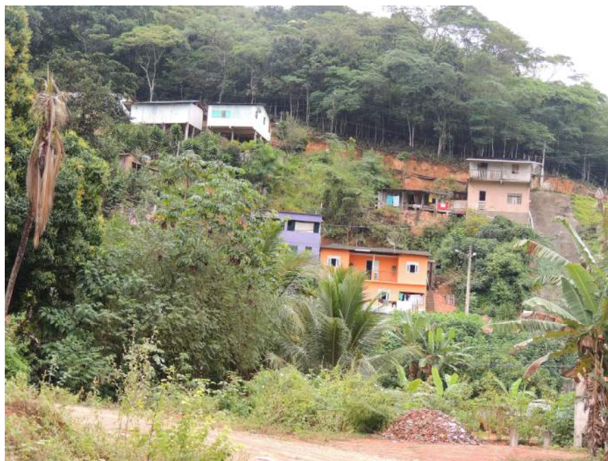
Foto 31 – Vista frontal do setor de risco. Indícios de instabilidade ao longo da encosta.
