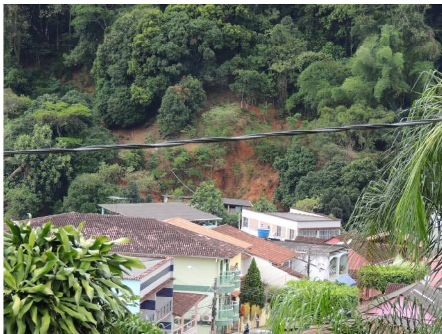
Foto 27 – Indícios de instabilidade a montante do domicílio.
