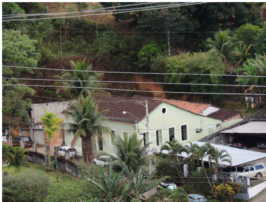
Foto 26 – Talude de corte nos fundos da edificação.
