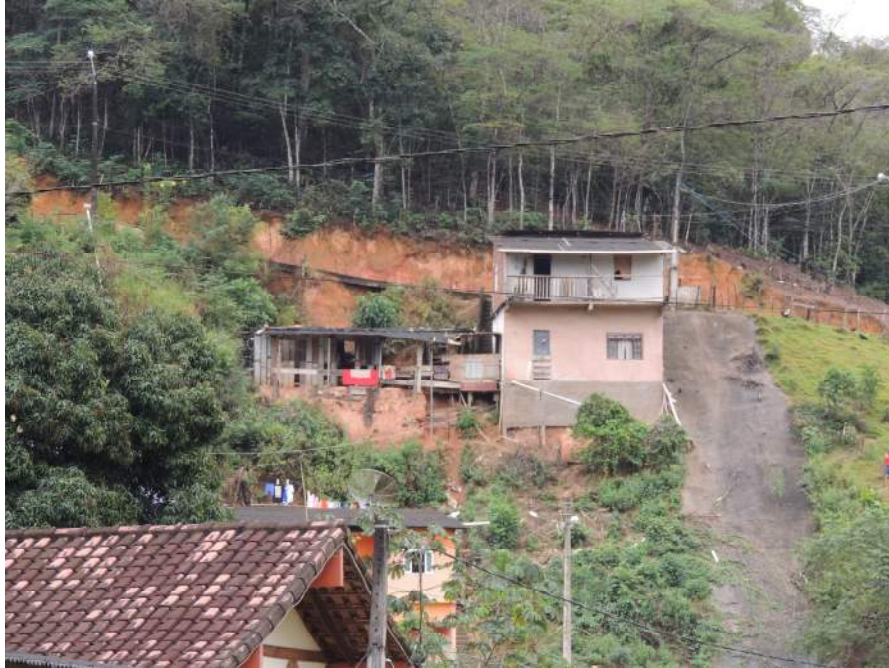
Foto 32 – Vista aproximada do setor com detalhe para estabilização parcial da encosta.
