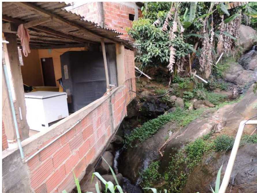
Foto 21 – Domicílios construídos sobre o maciço e linha de drenagem.
