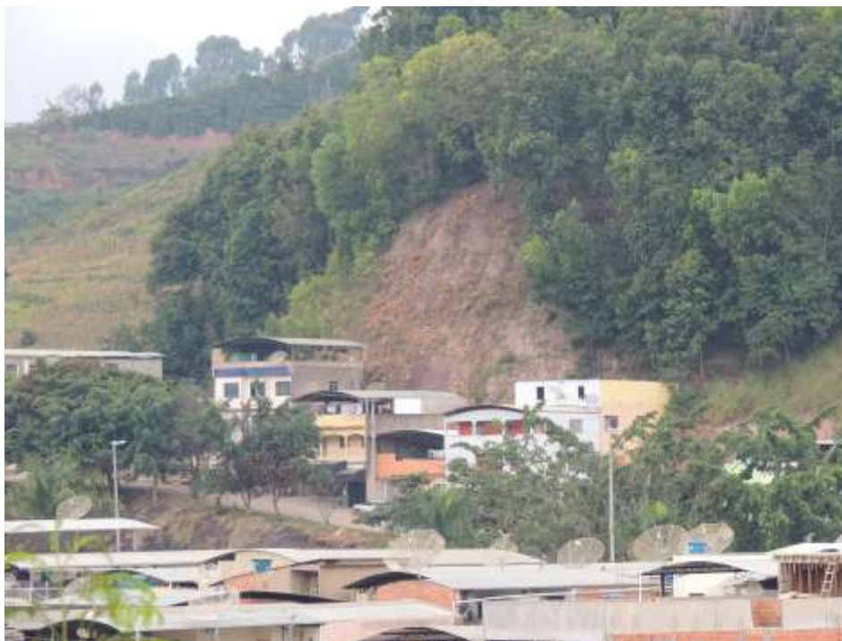
Foto 15 – Talude de corte com altura superior a 15,0m e ocupações na base.
