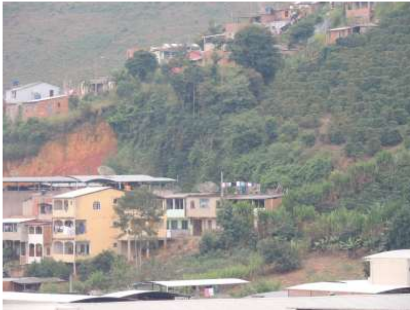
Foto 3 – Vista aproximada da área com detalhe para o trecho onde ocorreram movimentos de massa e para os outros domicílios construídos na base da encosta.
