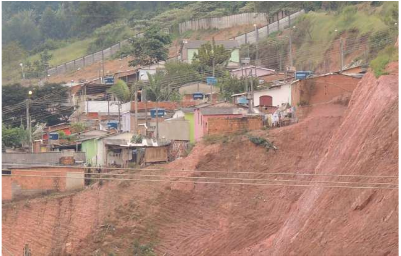
Foto 17 – Detalhe para o padrão construtivo e para os taludes de cortes nos fundos dos domicílios e compõem o setor.
