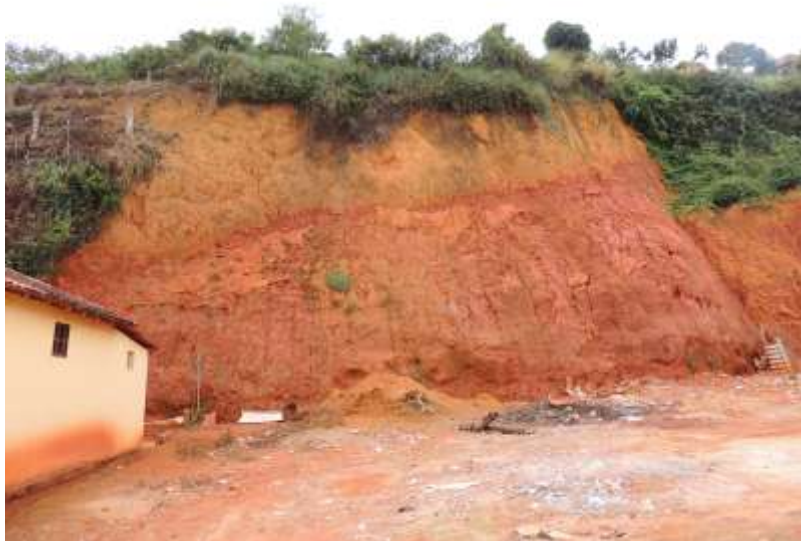
Foto 5 - Contato entre solo residual mais alterado no topo e o solo menos alterado com estruturas incipientes na base.
