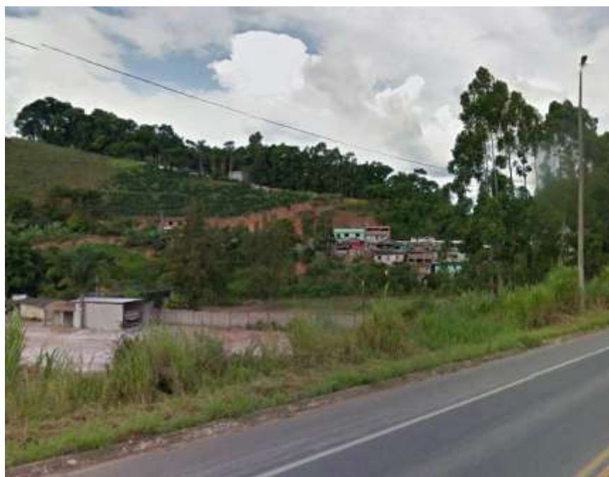
Foto 20 – Vista frontal do setor de risco com detalhe para os taludes de corte instáveis nos fundos dos domicílios.
