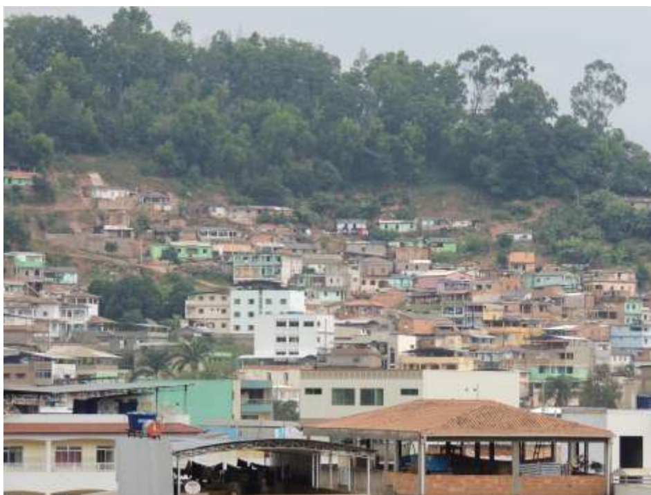
Foto 12 – Vista panorâmica da encosta onde o setor de risco se insere com destaque para a forma de ocupação e o padrão construtivo que diminui em relação ao topo.
