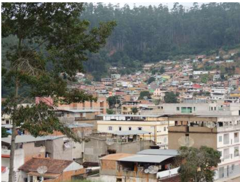
Foto 9 - Vista panorâmica da encosta onde o setor de risco se insere com destaque para a forma de ocupação e o padrão construtivo que diminui em relação ao topo.
