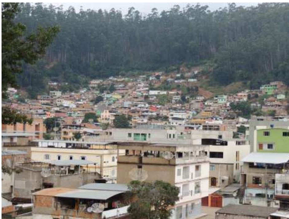
Foto 18 – Vista panorâmica da encosta onde o setor de risco se insere com destaque para a forma de ocupação e o padrão construtivo que diminui em relação ao topo.
