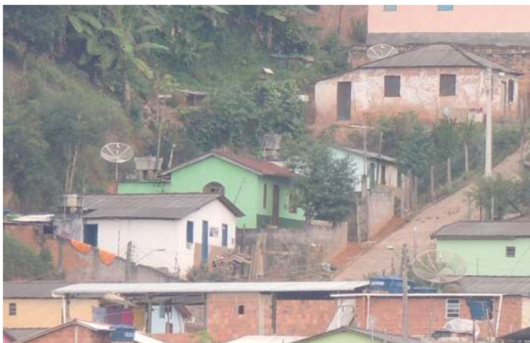
Foto 11 – Detalhe entre o baixo padrão construtivo dos domicílios e a proximidade dos mesmos em relação aos taludes laterais gerados por meio de cortes.
