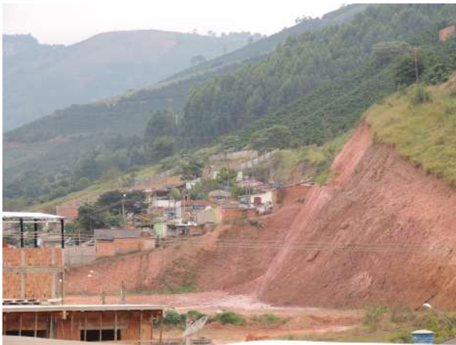
Foto 16 – Domicílio de baixo padrão construtivo e talude de corte com altura superior a 20,0m próximo ao setor.
