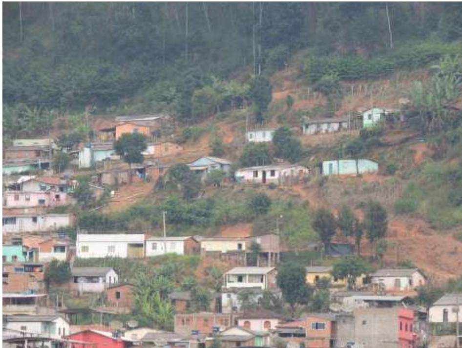
Foto 19 – Detalhe para o baixo padrão construtivo e para os taludes de corte sem quaisquer contenções.
