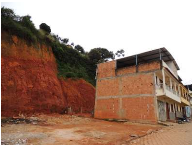
Foto 4 – Foto a partir da base da encosta com detalhe para a altura do talude de corte. Notar volume de solo deslizado nos fundos do domicílio.
